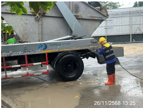
รูปที่ 16 ฉีดล้างล้อรถบรรทุก
