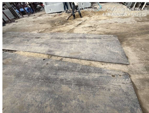
รูปที่ 31 ปูแผ่นเหล็ก
